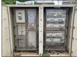
Fotografia 04 Quadre Ajuntament (enllumenat, caseta Creu Roja, barraques, etc.) amb comptador.
