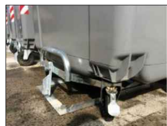
Ancoratge de ferro galvanitzat en calent, per immersió. Fixació per mitjà de tac químic Fixació contenidors d'escombraries.
