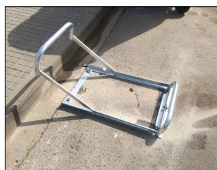
Ancoratge de ferro galvanitzat en calent, per immersió. Fixació per mitjà de tac químic Fixació contenidors d'escombraries.
