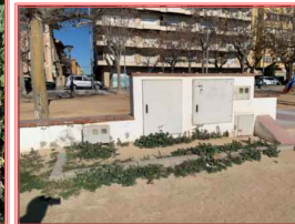
Fotografia 13 CDU, dos armaris de comptadors i dos armaris d'enllumenat, xiringuito Onada, pilones de connexió passeig i Àrea activa de la platja.
