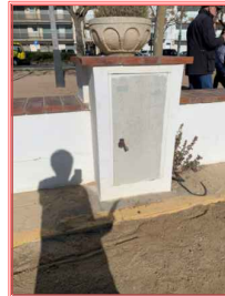
Fotografia 06 Armari de seccionament d'Endesa.
