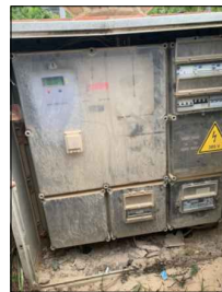
Fotografia 10 Quadre d'enllumenat per fires, llums platja, etc. amb comptador.
