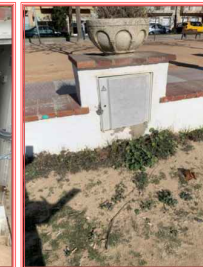
Fotografia 16 CDU on s'hi connecten els firaires i d'on surten les seves línies i connexions que realitza Endesa.
